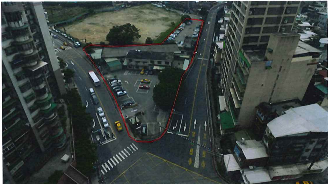
圖 4-7 軍備局及麵粉廠工地現況
