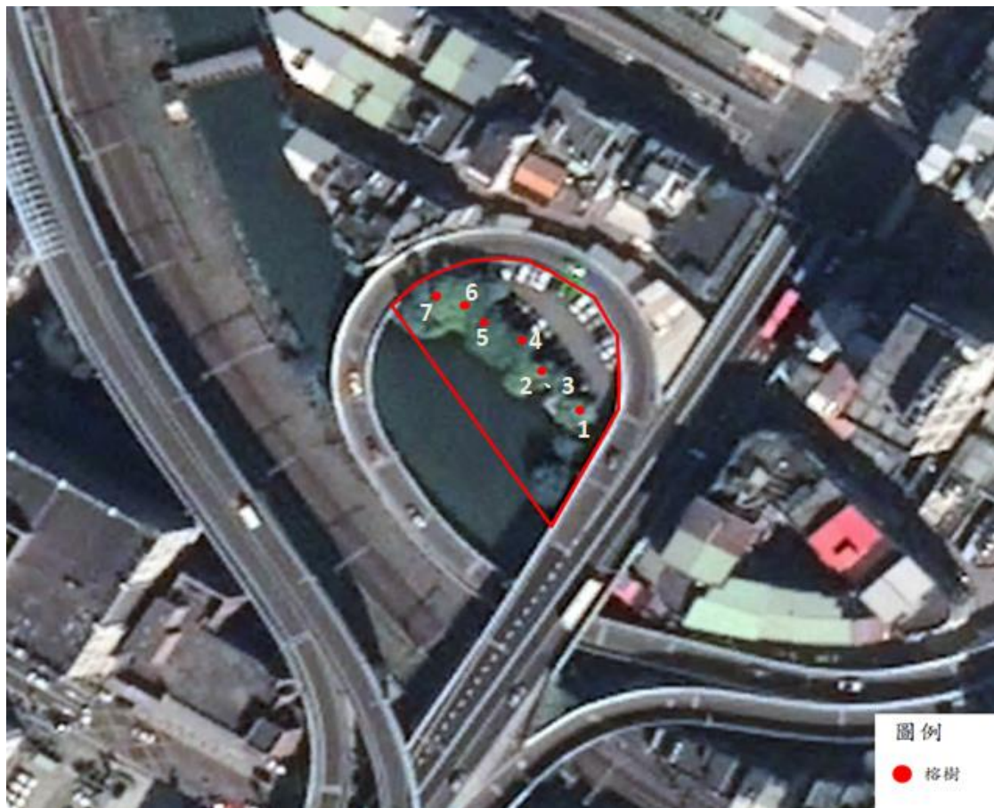
圖二 旭川河沉沙池工程保全對象生態關注區位圖(大樹)
